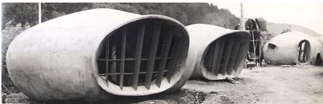
Technique du voile de béton projeté sur les bulles - 1967 (@ FRAC Centre Orléans)
