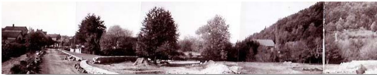
Travaux de terrassement sur l'île en 1967 (@ FRAC Centre Orléans)
